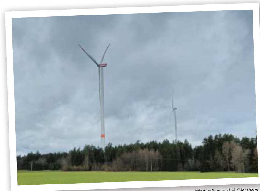
Windkraftanlage bei Thiersheim
